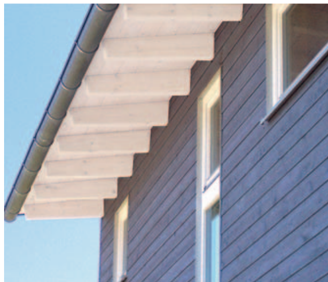
Abb. 2: Mit den Systemlösungen im Rahmen der Delta Greywood-Farbkollektion erreicht man sofort eine gleichmäßige Silberpatina-Anmutung ohne die bei einem natürlichen Vergrauungsprozess unvermeidlichen Flecken und Schlierenbildungen.
