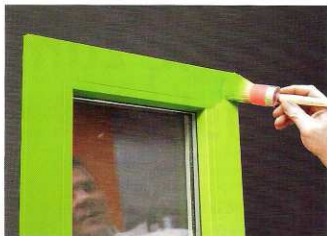
Vorteile des Eintopfsystems: Die Schlussbeschichtung für die Kunststoff-Oberflächen erfolgt mit demselben Material.
