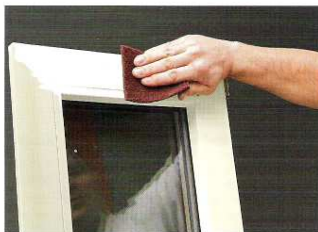
Der Kunststoffuntergrund wird zunächst gründlich gereinigt und entfettet und mithilfe eines Schleifvlieses angeraut.
