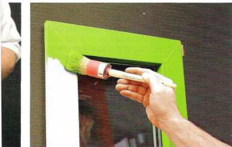
Wirtschaftlich und zeitsparend kann das Material auf PVC ohne vorherige Grundierung appliziert werden.
