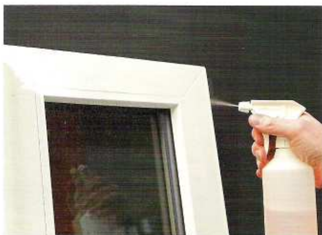
Der Kunststoffuntergrund wird zunächst gründlich gereinigt und entfettet und mithilfe eines Schleifvlieses angeraut.
