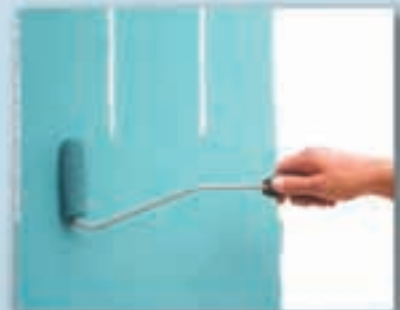
bahnenweise satt vorlegen.
