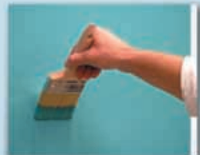
Anschließend den gleichmäßig verteilten Lack mit dem Flachpinsel „durchziehen“.
